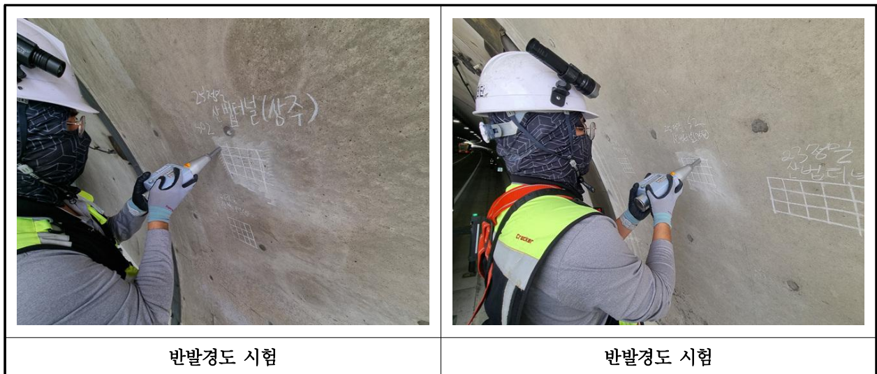
【사진 2.4.2】 반발경도시험 현장사진
