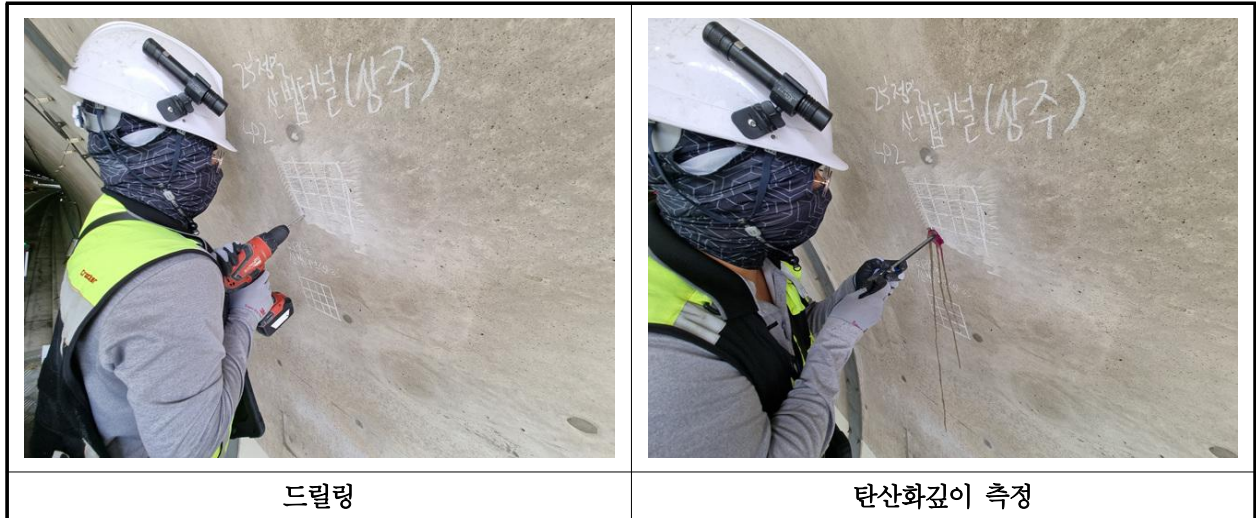
【사진 2.4.3】 탄산화 깊이 측정 현장사진
