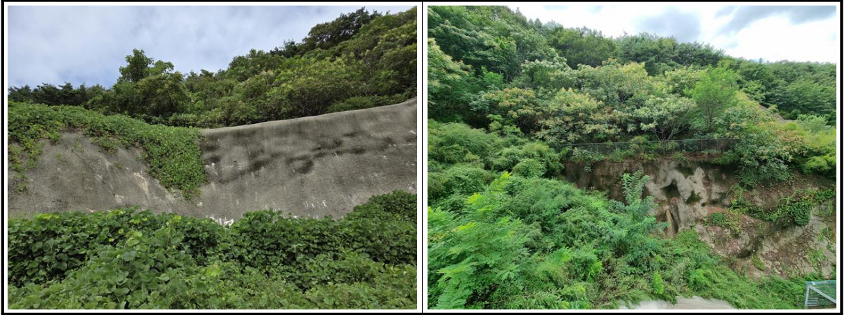
【사진 2.3.7】 사면 전경
