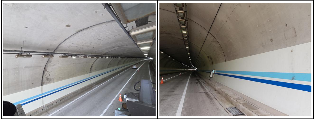
【사진 2.3.3】 라이닝 측벽부 전경
