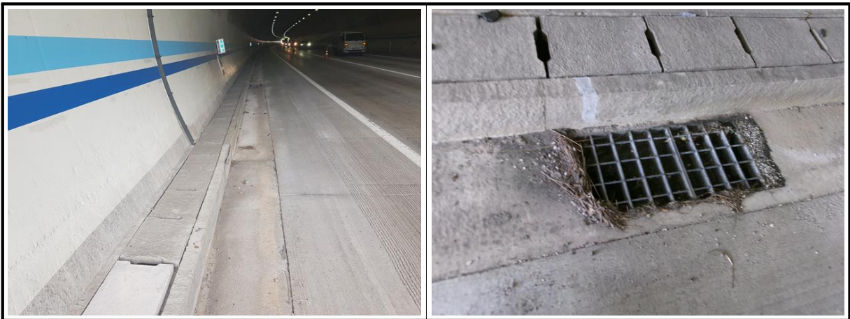
【사진 2.3.23】 공동구 및 배수시설 전경
