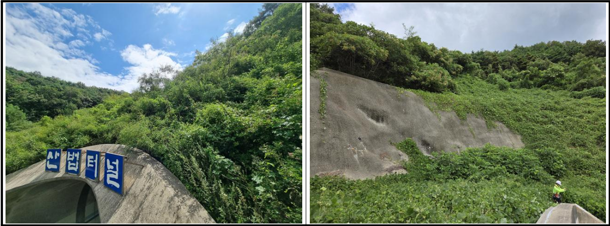
【사진 2.3.21】 사면 전경
