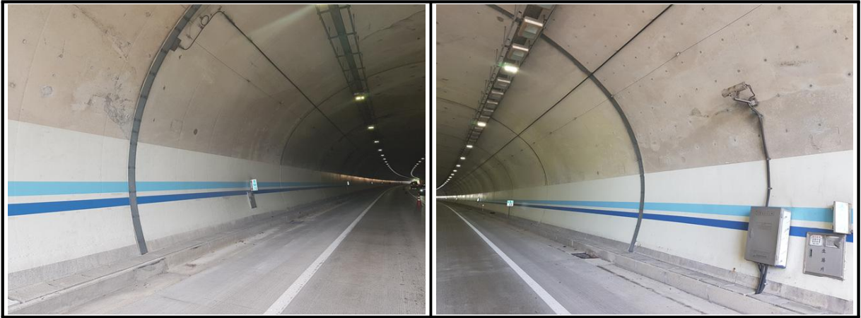
【사진 2.3.17】 라이닝 측벽부 전경
