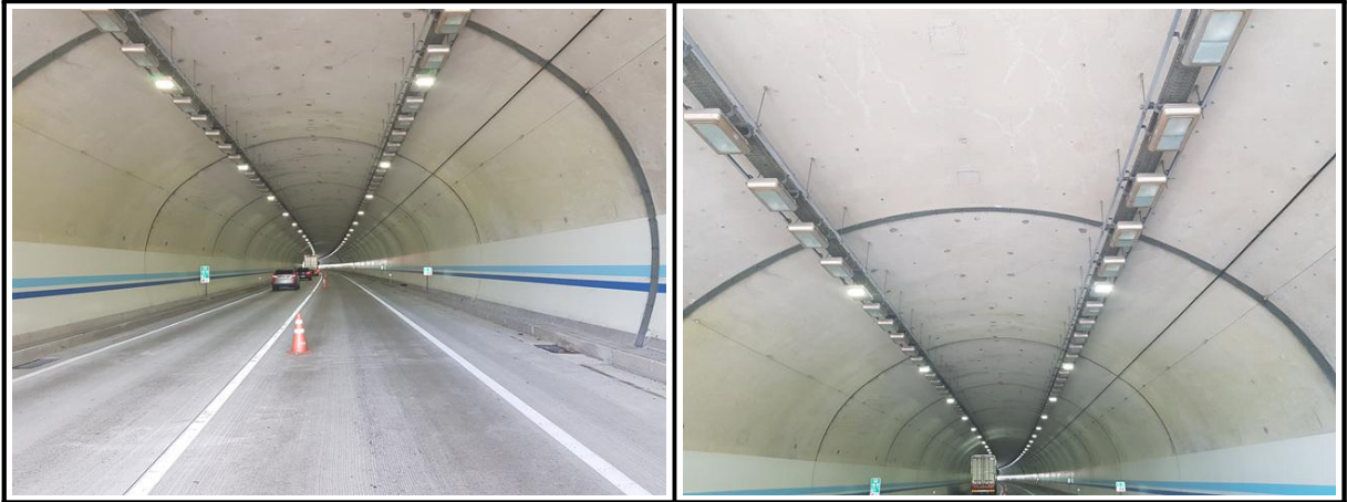
【사진 2.3.15】 라이닝 천단부 전경
