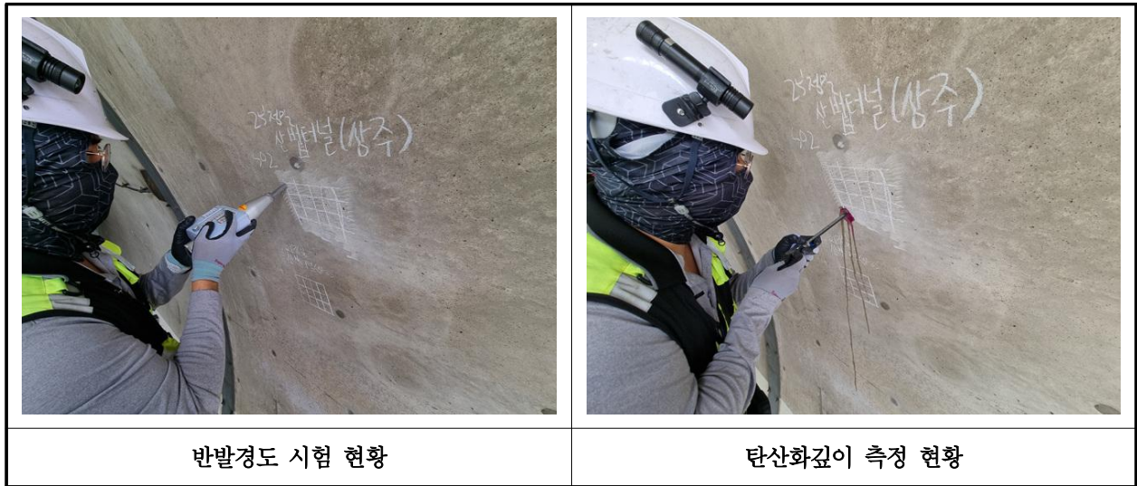
【사진 2.4.1】 콘크리트 내구성조사 현황
